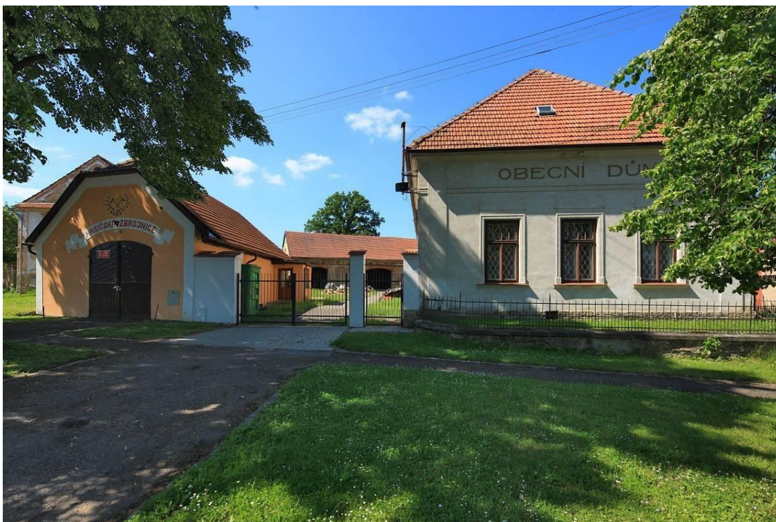
Fotografie: Vpravo budova OÚ, vlevo budova hasičské zbrojnice. V pozadí za branou sběrný dvůr a obecní stodola
